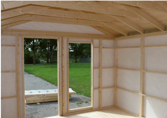
Innenansicht, Wände mit Windschutzfolie
